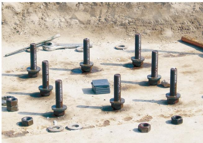
...столбы можно устанавливать на фундаменте только на связанный бетон.
